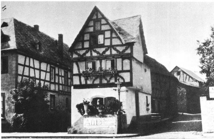
Afb. 7. Bij hoog water kwam het water tot de 2e verdieping.
