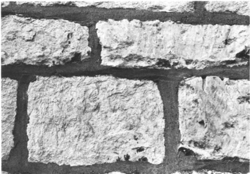
Fig. 6 Bouwstenen uit de Kalksteen van Vylen. A Detail van een oud muurgedeelte met oorspronkelijke voeg. Bakhuis no. 2 van het Panhuiscomplex te Vylen. Foto: W. M. Felder, 1973. B Detail van een oud muurgedeelte met nieuwe voeg. Kerk te Holset. Foto: W. M. Felder, 1973.
