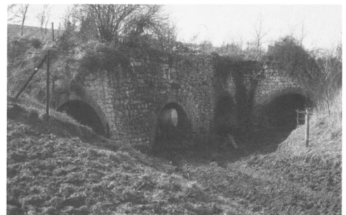
Fig.8. Viervoudige kalkoven bij Voerendaal.
