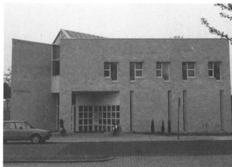
Fig. 4. Arbeidsbureau te Valkenburg, gebouwd uit gezaagde blokken Maastrichtse kalksteen (Sibbersteen).
