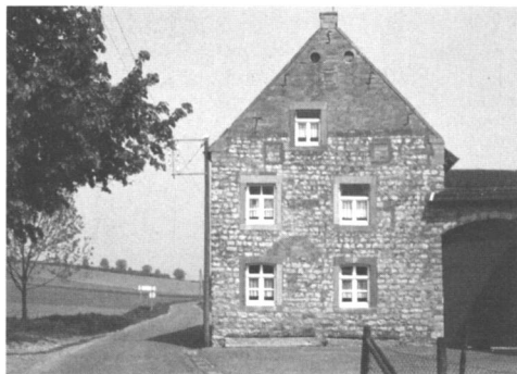
Fig. 6. Winthagerhof te Winthagen. Fraaie 18e eeuwse hoeve, geheel gebouwd uit Kunrader kalksteen (deels bekapt, deels breuksteen). De geveltop werd later verhoogd met gezaagde blokken Maastrichtse kalksteen. De huidige vensteromlijstingen zijn uit ondercarbonische kalksteen (kolenkalk). De oude dichtgemetselde vensteromlijstingen zijn uit Nievelsteiner zandsteen (Tertiair).
