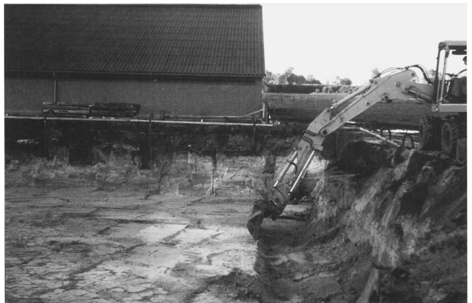
Afb. 1. Uitgraven van de bouwput voor de gierkelder van een veestal, Ketelgatstraat 15, Olst (1990). Links onder de beschreven structuurbodem.
