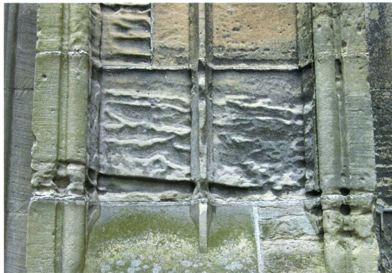
Afbeelding 10. Sterk verweerde Udelfanger zandsteen aan het portaal van de Pandhof naast de Domkerk in Utrecht. Subtiële verschillen in korrelgrootte en verkitting resulteren in differentiële verwering, waardoor de sedimentaire gelaagdheid wordt geaccentueerd.
