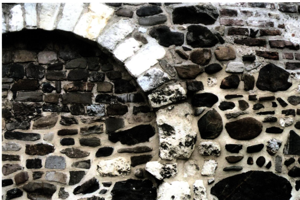
Afbeelding 11. Een close-up van de Maasgesteenten in de kapel bij de basi- liek van Sint Odiliën- berg (Nederland).
