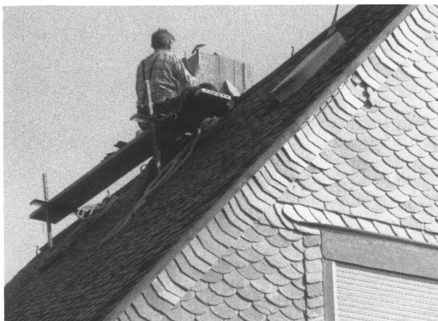
Afb. J - 7. Leiddekker aan het werk. De leien worden in Duitse dekking gelegd (schubdekking).
