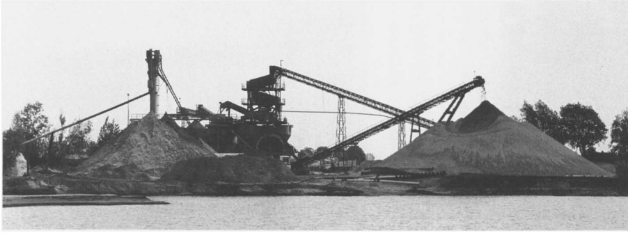
Afb. 7. Sorteersinstallatie van een grind- en zandzuigbedrijf in Netterden (Provincie Gelderland). (Foto: J. Gal)
