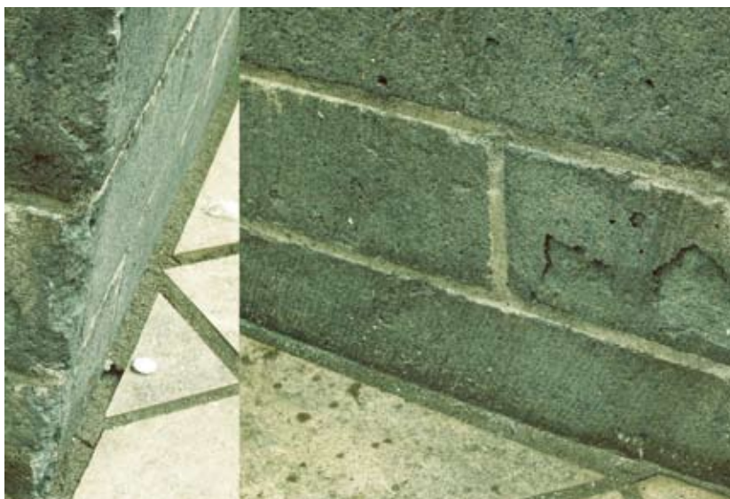
Afb. 9. Verwerking van Reimerath-trachiet aan de plint van de toren van de Catharinakerk te Doetinchem (dec. 2007).
