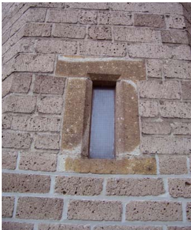
Afb. 8. Reimerath-trachiet als raamlijst aan de traptoren van de Catharinakerk te Doetinchem (dec. 2007).
