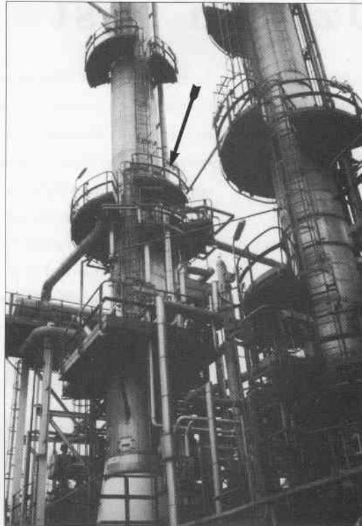
De vindplaats van het nest, tien meter hoog in toren 6702 van de waterstofplant. (foto: Kees Moeliker)
