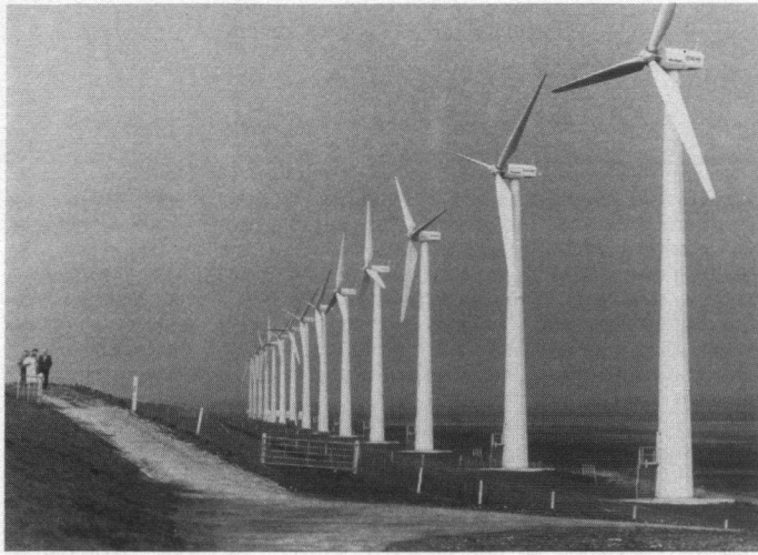
Windpark IJsselrij ten noorden van Urk, een drie kilometer lange lijnopstelling van 25 Windmaster windturbines van elk 300 kW. Foto: CEA, Rotterdam.
