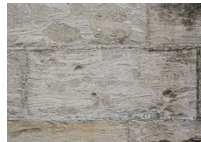
AFBEELDING 9. | Detail van Brusselse steen (Gobertange variant) met kenmerkende laminaties en een patroon van ronde en ovale graafgangen, Postgebouw, Gent.
