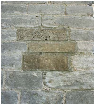
AFBEELDING 11. | Drie blokken Ledesteen (roestbruin) tussen Brusselse steen, Diegem-variant (grijze kleur). De Ledesteen is hier te onderscheiden door de kleur, de macroporositeit en de concentratie van nummulieten in sommige delen van het blok. Het formaat is typisch voor Brusselse steen. Sint-Michielskerk, Gent.
