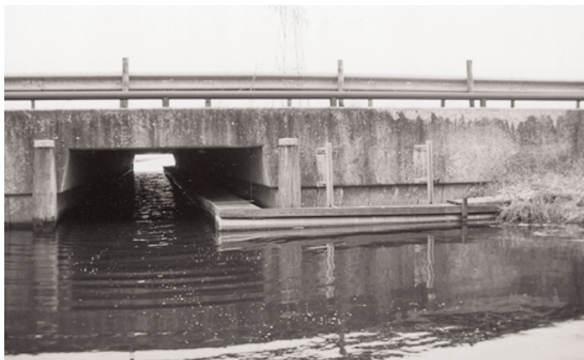
Een loopstrook onder de brug.
