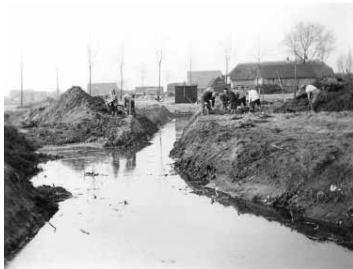
Afbeelding 3. Tijdens de ruilverkaveling werden oude sloten gedempt en vervangen door nieuwe rechte sloten.
