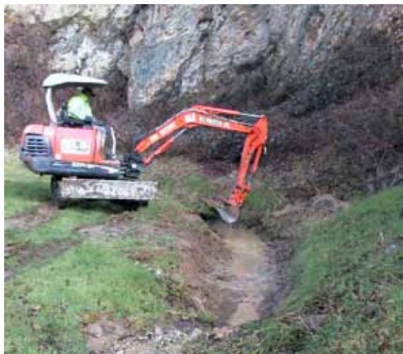
Foto 3 Het dempen van de geul langs een weg bij Evaux (september 2009).
