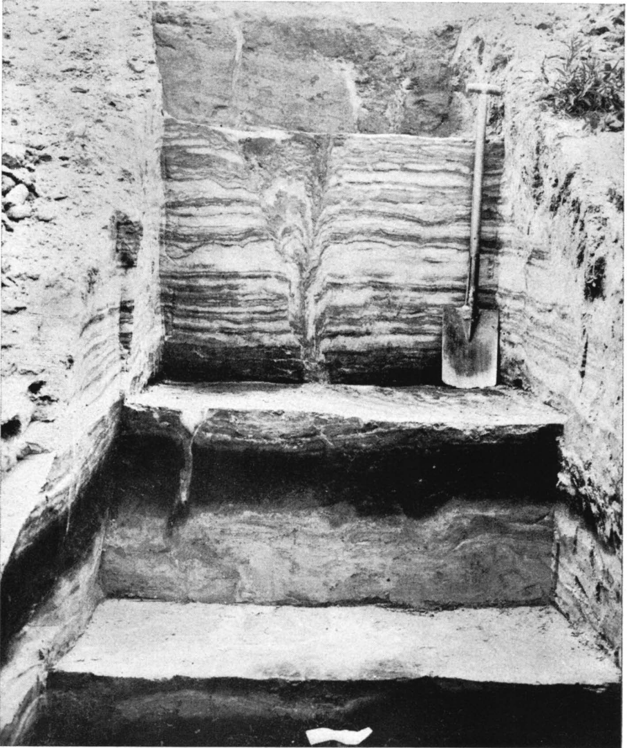
Afb. 18. Ontsluiting bouwput Hengelo (1934).
