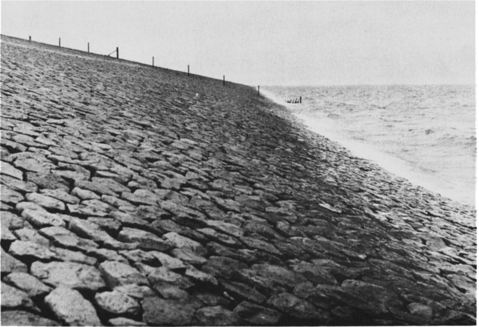
Dijkglooïing met jongere bekleding van basalt.
