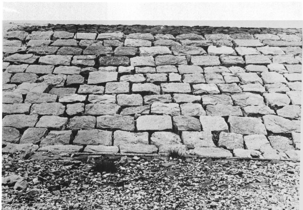
Foto boven: Dijkvloeiing met oudere bekleding van Noordse steen.
