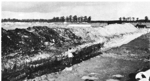
Afb. 7. Een beeld van het gedeelte van de Duckenburg, waar de vernielingen al begonnen zijn. In de wand van een rioleringsleuf is fraai de (zwarte) veenopvulling te herkennen van een oude rivierarm. Terzijde gaat deze opvulling in (grijze) kleiige afzettingen over en vervolgens in (heldergele) grindzanden. De kleibedekking van het geheel is op de foto nog te herkennen. Op de hier weergegeven plek werd aan de basis van de beddingopvulling een Bølling-niveau aangetroffen.
