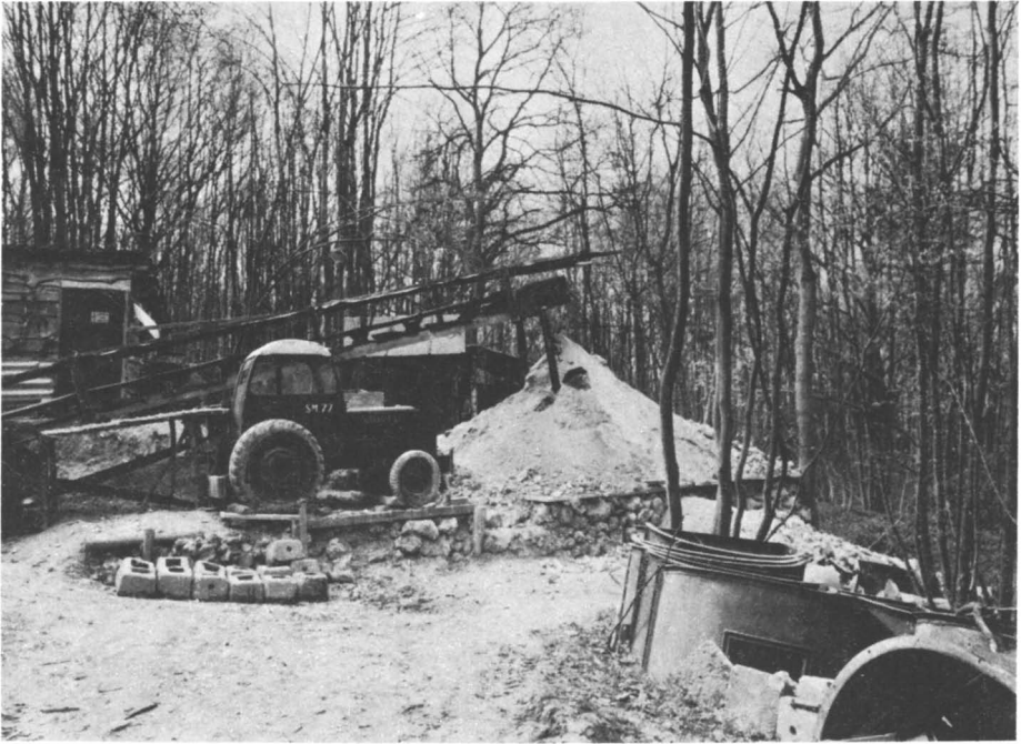
Foto 1. De laadplaats waar de uitgegraven kalksteen en opvulling van de prehistorische mijngangen en schachten verladen kan worden om buiten het natuurreservaat gestort te worden.
