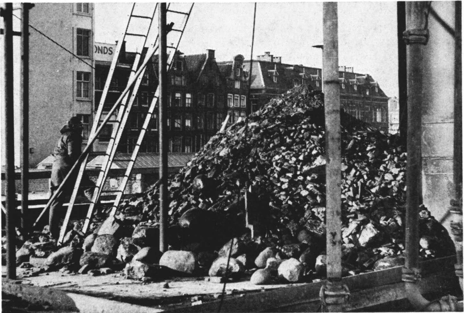
Stortplaats op het caisson van noordelijke zwerfstenen en van het overige in de tekst genoemde materiaal. Foto A. W. Burger
