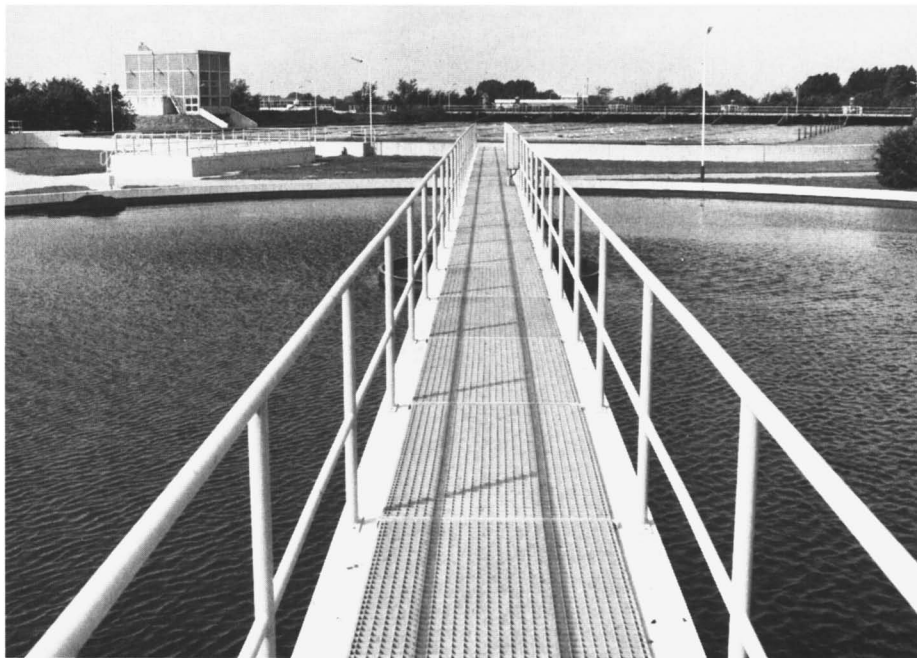
Overzicht gedeelte van de waterzuiveringsinstallatie Geestmerambacht in Warmenhuizen.
