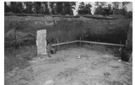
Afb. 3. De bouwput voor de rioolwaterzuiveringsinstallatie te Olst
