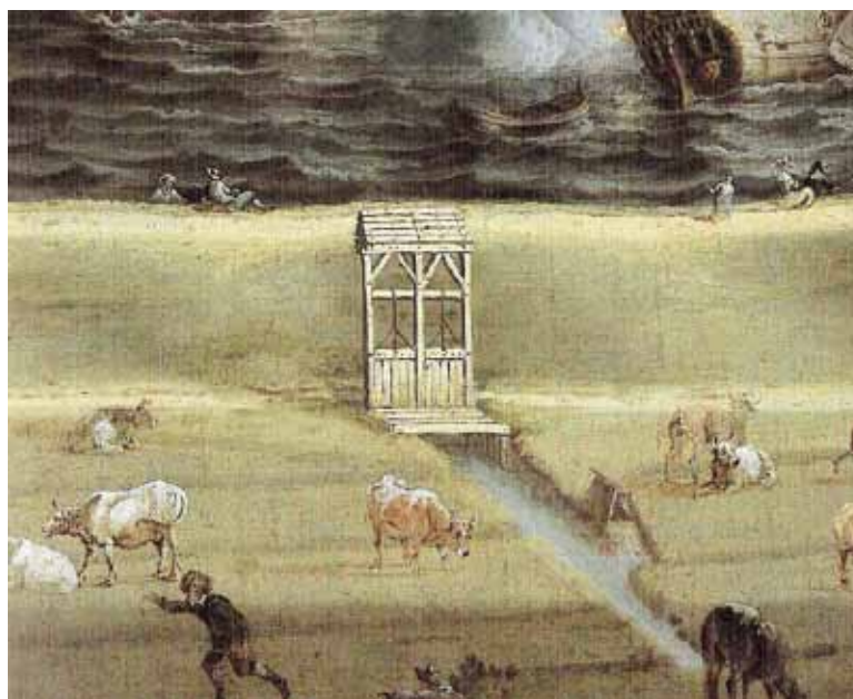
Houten spuisluis. Geen hindernis voor intrekkende glasalen (Bron: onbekend)
