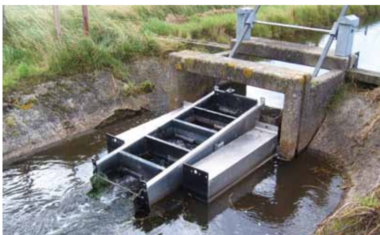
De testopstelling met prototype 1 bij Waterschap Veluwe in 2007 (Foto: Jasper Arntz)
