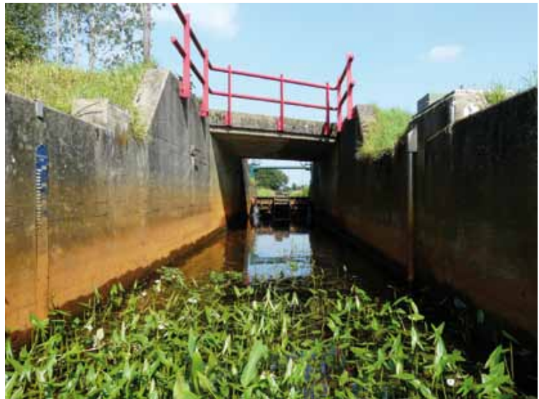
De complexe locatie waar Waterschap Aa & Maas met behulp van een Meyberg-vispassage invulling heeft gegeven aan een natte ecologische verbindingzone (Foto: Jasper Arntz)
