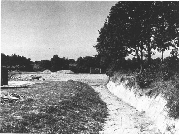
Afb. 1. Sleuf met geologisch profiel in het geologisch monument "De Zândkoele".
