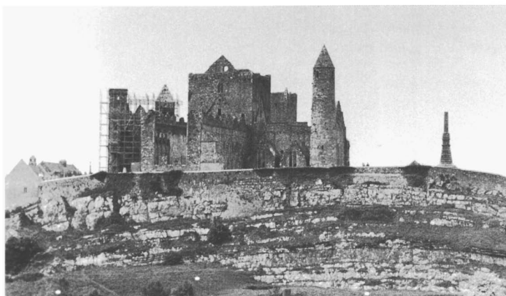
Afb. 17 A. De Rock of Cashel is een prominente, plaatselijke opwelling (monocline) van overigens horizontaal liggende Carbonische kalksteen in een vlak, door glaciale 'drift' bedekt landschap ten oosten van Tipperary. Van het grijze kalkgesteente ter plaatse is het complex gebouwd dat deze heuvel bekroont: een kasteel van de koningen van Munster, een kapel, een kathedraal met round tower en een begraafplaats met high cross.
