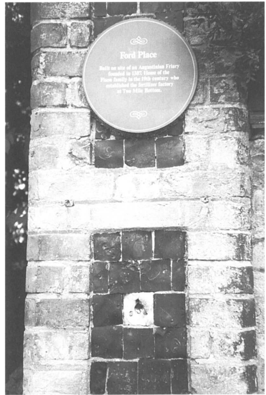
Afb. 3. (Rechts) Flushwork: bijna naadloos aan- gebracht. Ingang Ford Place, Thetford.
