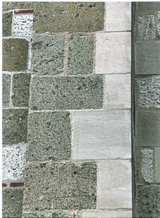
Afb. 6 met inzet afb. 7. De Sankt Georg in Nördlingen, gebouwd uit sueviet, het poreuze, snel verwerende tufachtige gesteente, waardoor regelmatig herstelwerkzaamheden nodig zijn (inzet).
