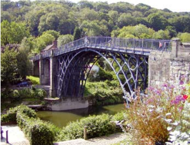
Afb. 4. De Iron Bridge, duidelijk zichtbaar zijn de vier ijzeren bogen die de overspanning vormen. (bron: http://www.transportcafe.co.uk/image16/iron-bridge_shropshire_thomas_telford.jpg ).
