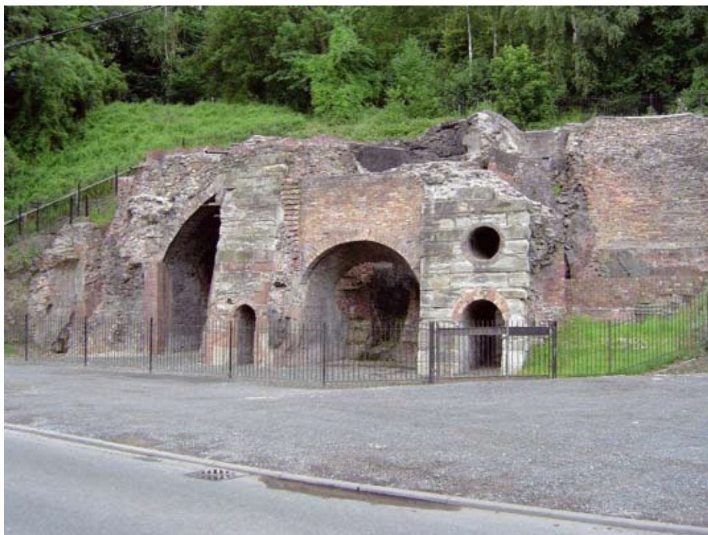
Afb. 2. De restanten van de ovens van Abraham Darby III, die te zien zijn in het Ironbridge Gorge Museum.
