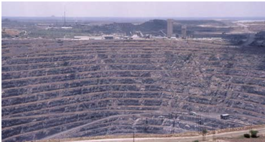
Afb. 1. De Phalaborwa-mijn gezien vanuit het noorden. De bodem op 760 m diepte is hier niet te zien. De donkere banden in de wand zijn aangesneden dolerietgangen. Op de achtergrond zijn de torens van de in aanbouw zijnde schacht te zien en de kopersmelterij.
