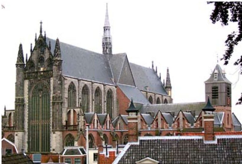
Afb. 1. De nooit voltooide Hooglandse of St. Pancraskerk; het voltooide transept is grotendeels opgetrokken in witte Belgische steen, met daarnaast Bentheimer zandsteen.
