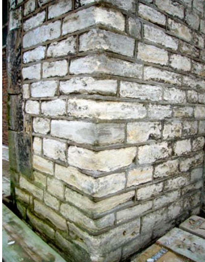
Afb. 4. Detail van het parament van het zuidtransept van de Pieterskerk, overwegend bekleed met Gobertange (dec. 2006).
