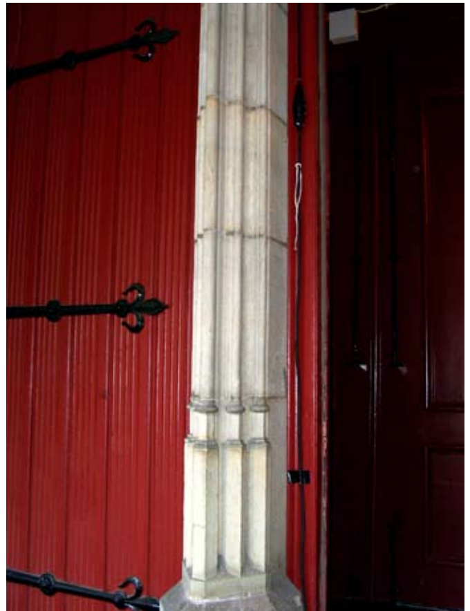
Afb. 12. Stijl in Oberkirchener zandsteen in het portaal van het transept van de Pieterskerk (apr. 2007).
