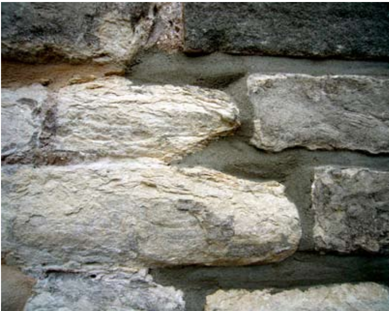
Afb. 19. Typische meelzakvormige verwerking van Gobertange aan het zuidtransept van de Pieterskerk (dec. 2006).
