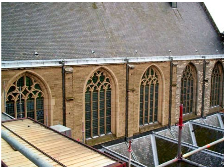
Afb. 11. Noordzijde van het schip van de Pieterskerk, waarvan de drie linker traveeën overwegend bekleed zijn met tufsteen, in het bijzonder Ettringer tuf (jun. 2005).
