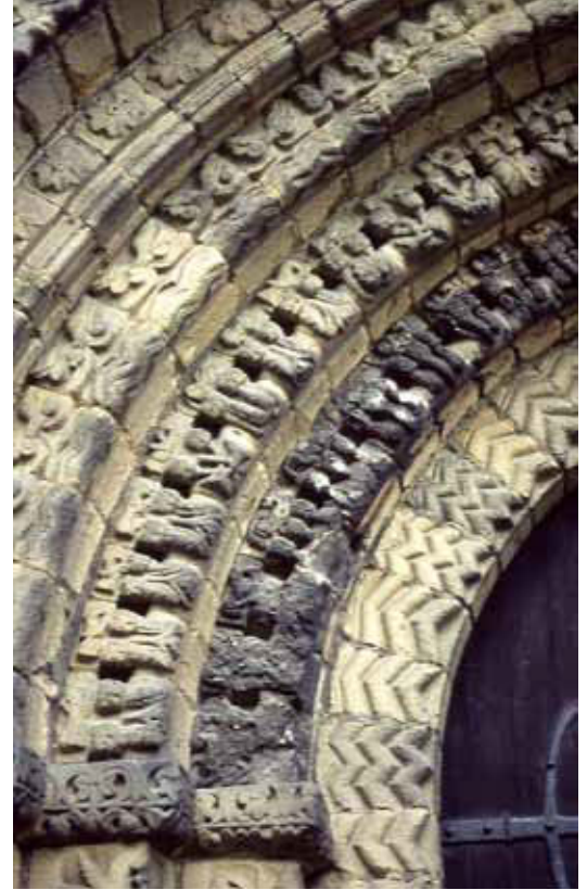
Afb. 4a en b. Westportaal uit ca. 1160 van de Priorij Kerk in Tutbury en detailopname (b) met binnenste boog van albast. De zwarte verweringskorst bestaat uit gips en ingekapseld roet.
