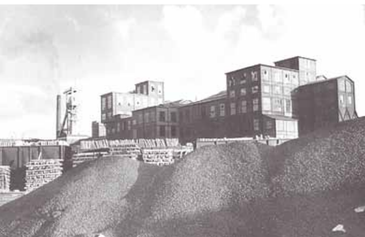
Afb. 4. Oranje-Nassau-1, schacht en zeeverijen.
