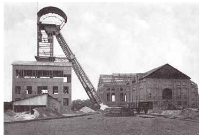
Afb. 5. Aanleg van de Oranje-Nassau-III, Heerlerheide.
