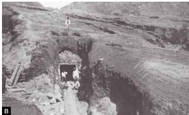
Afb. 5a en b. Werkzaamheden in 1925 en 1926 voor de aanleg van een tunnel door de kraterwand, om te voorkomen dat de krater vol zou lopen. (Foto 5a: mej. Stoll, 19 april 1925; foto 5b: Rudolf, september 1926).
