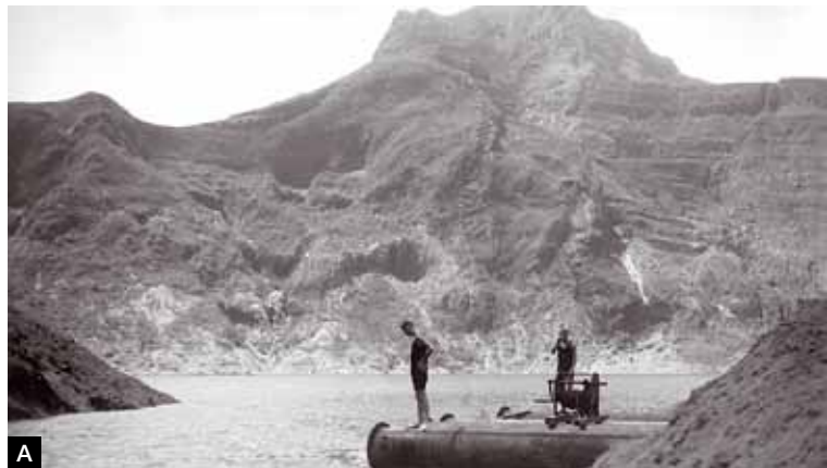
Afb. 5a en b. Werkzaamheden in 1925 en 1926 voor de aanleg van een tunnel door de kraterwand, om te voorkomen dat de krater vol zou lopen. (Foto 5a: mej. Stoll, 19 april 1925; foto 5b: Rudolf, september 1926).
