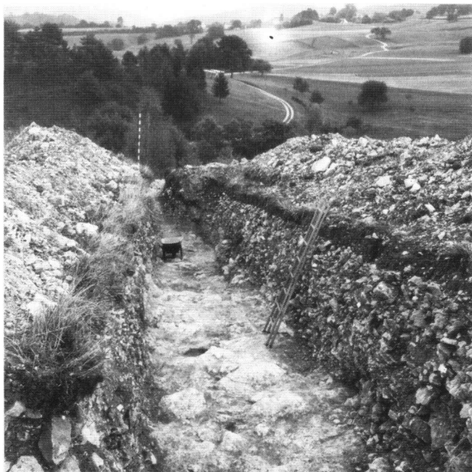
Abb. 4: Löwenburg (BE), Schnitt I, 20-40 m. Abgebaute Terrassensohle und Westprofil mit dem etwas verlagerten Bergbauschutt.
