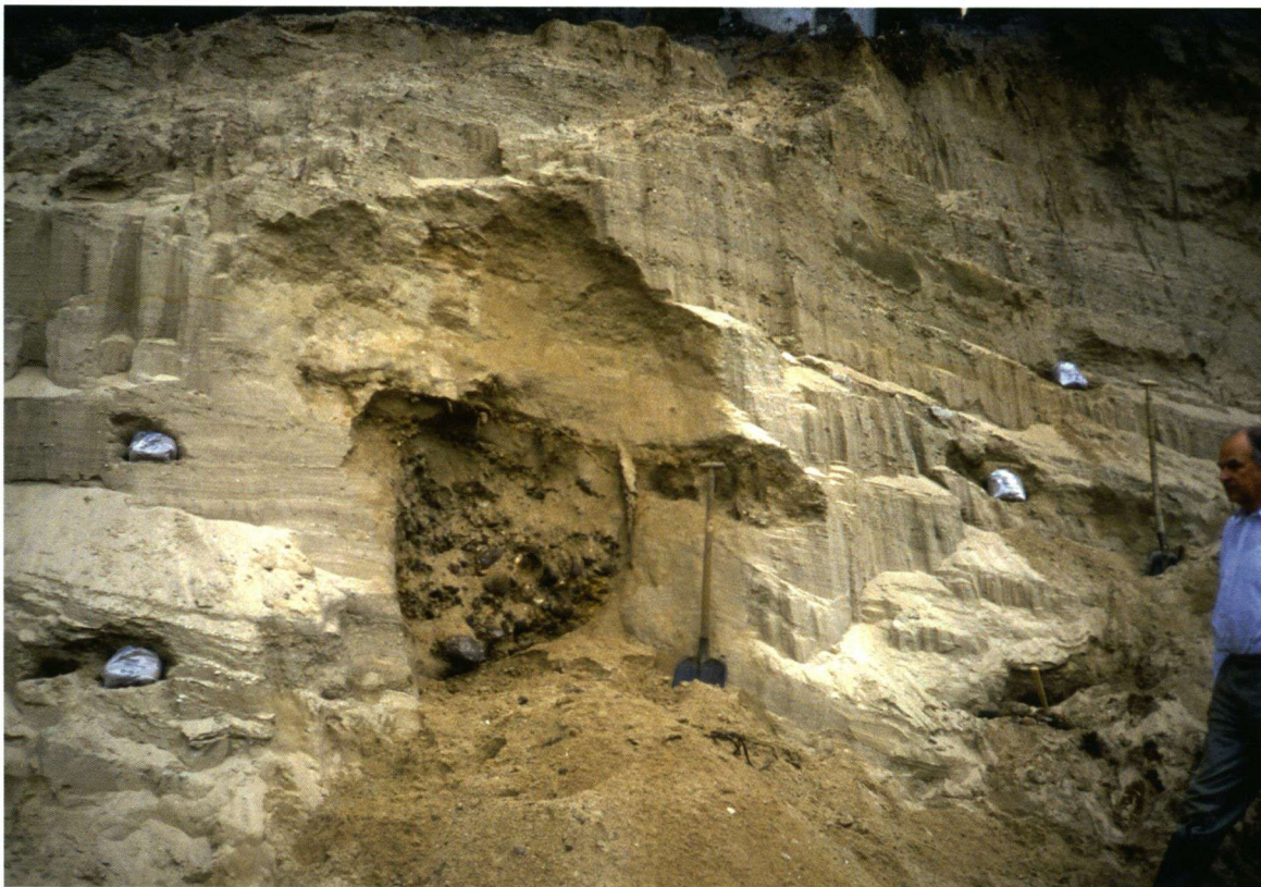
Afbeelding 12. De zuidwand van de bouwput AKN aan de 's-Gravelandseweg in Hilversum. In gestuwde rivierzanden van de Formatie van Urk bevindt zich een 'vulling' die rijk is aan Scandinavische stenen.
