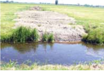
Figuur 6: Pas gedempte sloot die vervangen is door een drainagebuis in de Alblasserwaard. (Foto: Rombout van Eekelen)
