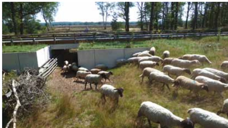
Figuur 3. Een belangrijk nevendoeel van het herpetoduct is het laten passeren van de schaapskudde onder de provinciale weg door, zodat een evenwichtige begrazingsdruk ontstaat. (Foto: S. Jansen).
