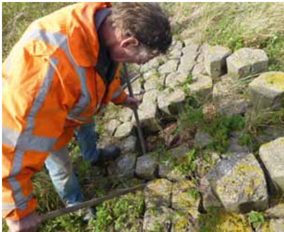
Steenzetter Johan van Dijk uit Kampen opent de steenlaag bij een vastgestelde overwinteringsplaats van ringslangen in de Zuidkade van Marken. (Foto: M. van Wieringen, Rijkswaterstaat)
