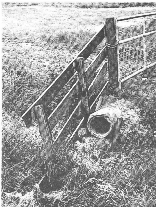
Ingegraven betonpijp - Waterland-Oost (Frans Parmentier)
