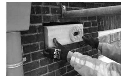
Het plaatsen van een beugelkast
