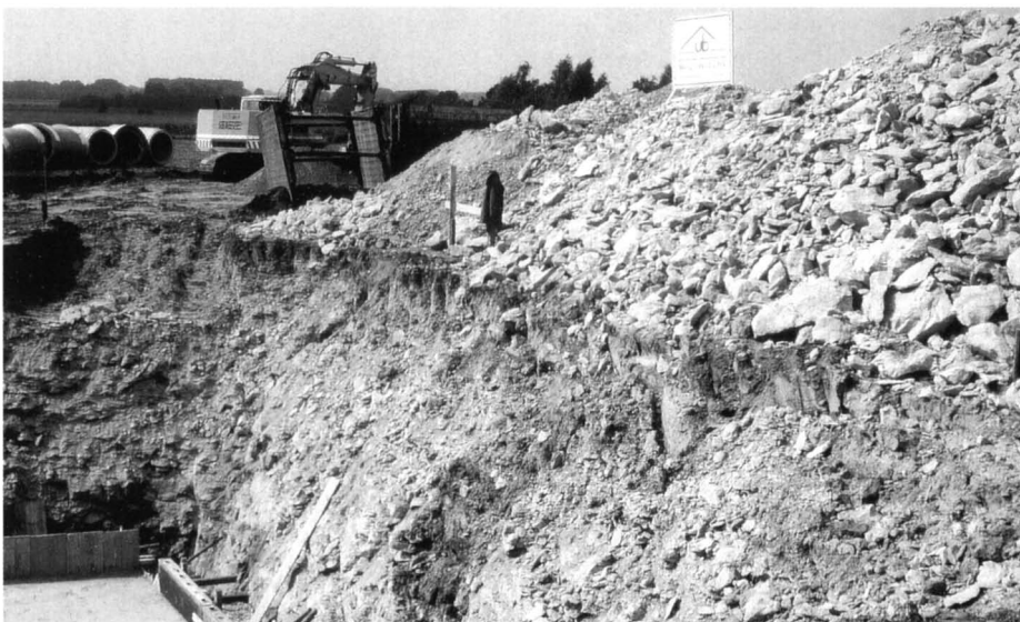
Afb. 1. Bouwput van de nieuwbouw fa. Borgmann, Coesfeld (opname 1991).
