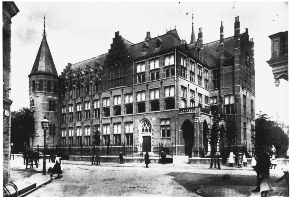
Fig. 1 Geologisch Instituut in 1902. Het gebouw is thans (1990) uiterlijk vrijwel ongewijzigd. De kleine schoorsteentjes rechts zijn afvoeren van zuurkasten.
