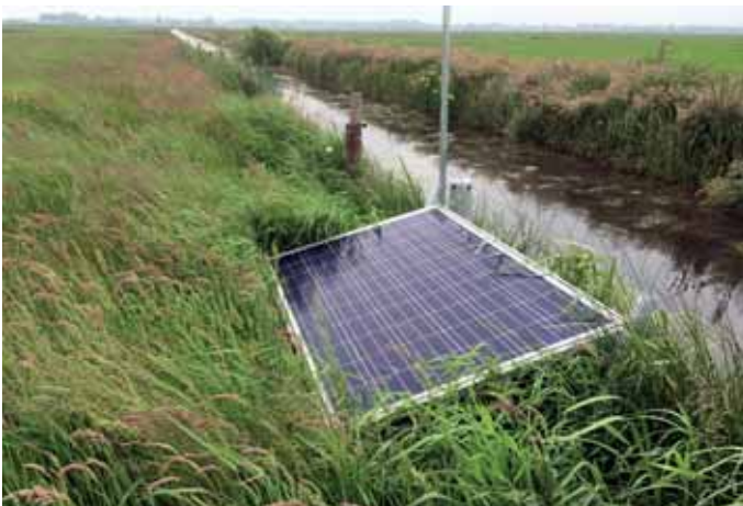
Vogels lok je met een hoog slootpeil of door een greppel met water, daarvoor moet het grondwaterpeil omhoog. De provincie Utrecht financierde daarvoor waterpompen op zonne-energie die in samenwerking met de agrarische natuurvereniging in Eemland konden worden geplaatst. Foto: R.A. Kole.
