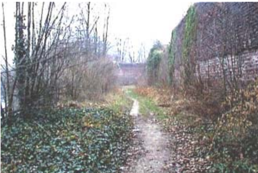
Een gedeelte van de vestingwerken van de Lage Fronten
