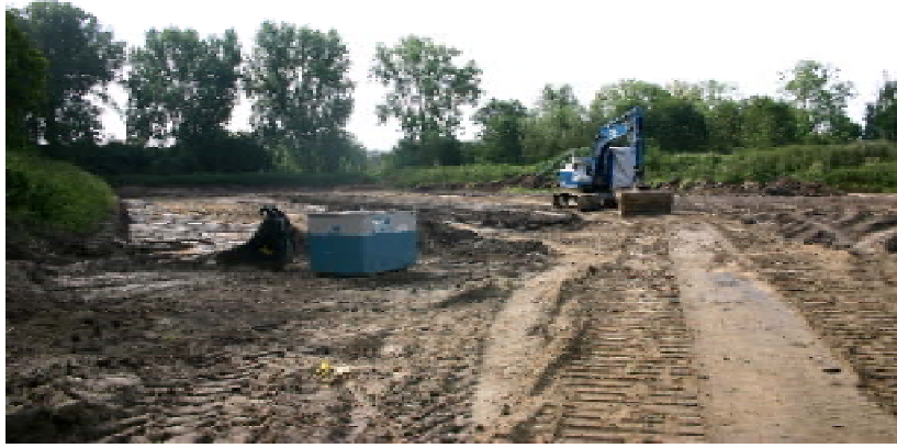
Foto 3: De gerijpte bagger wordt afgegraven (27 augustus 2005).
