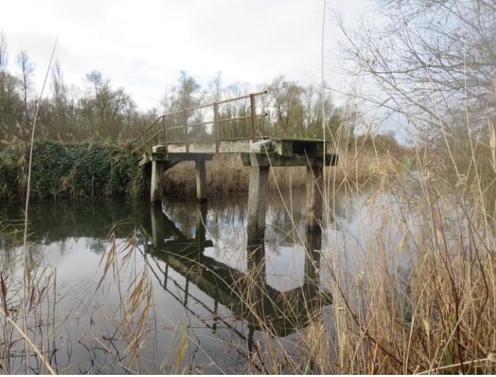
Foto 1. Halve brug over het Gat van Kielen.
