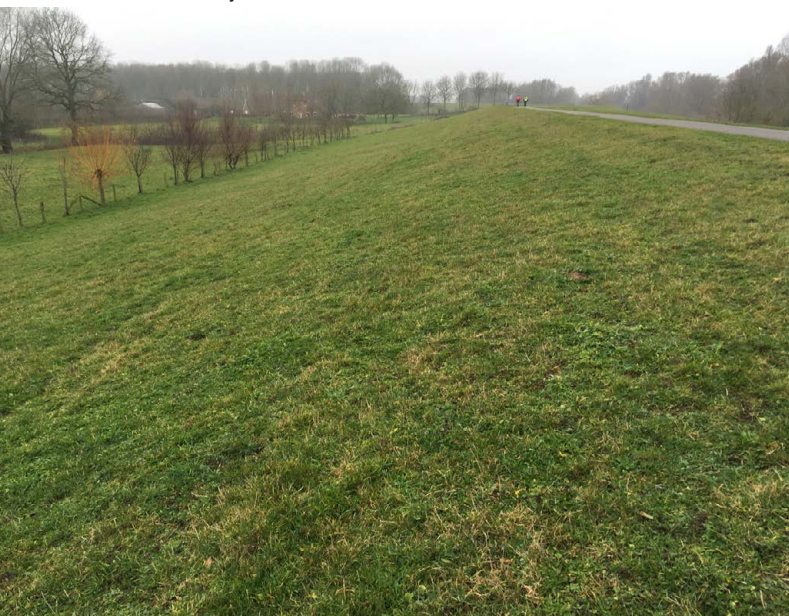
Afbeelding 6. De Waaldijk ten noorden van Beuningen, binnendijks talud verzwaard na het hoogwater van 1995, 7 januari 2020.
