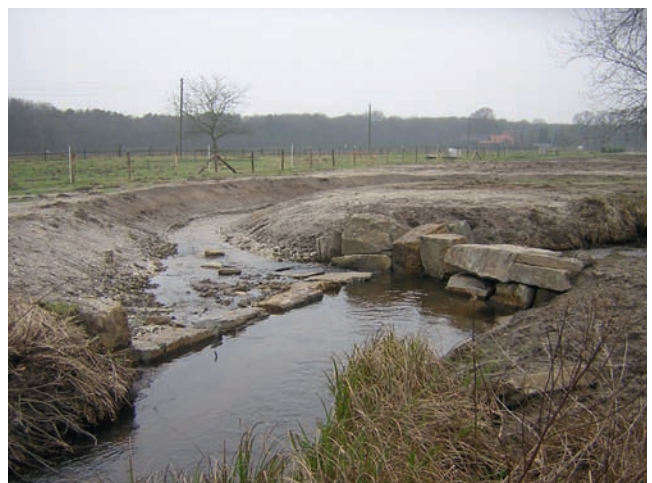
FIGUUR 4 Het nieuwe, uit grote stenen bestaande, waterverdeelwerk in de Rode Beek (foto: Rob Gubbels).
